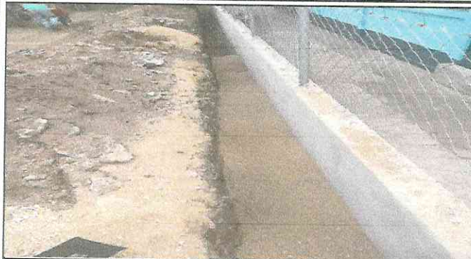
Finalizacion de muro perimetral.
