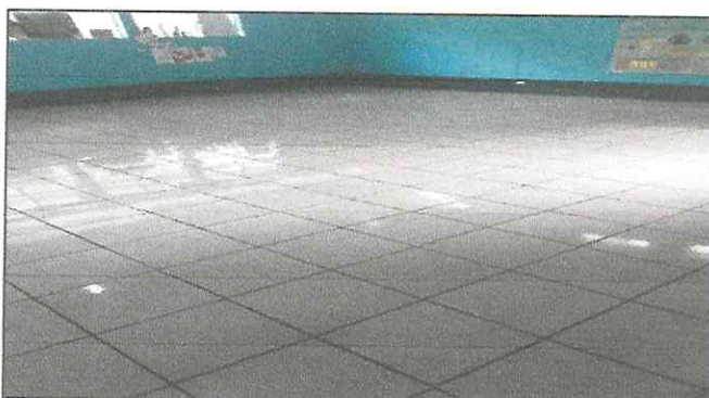
Finalizacion de pisos en aulas.
