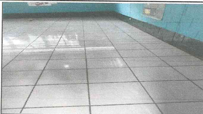
Finalizacion de pisos en aulas.
