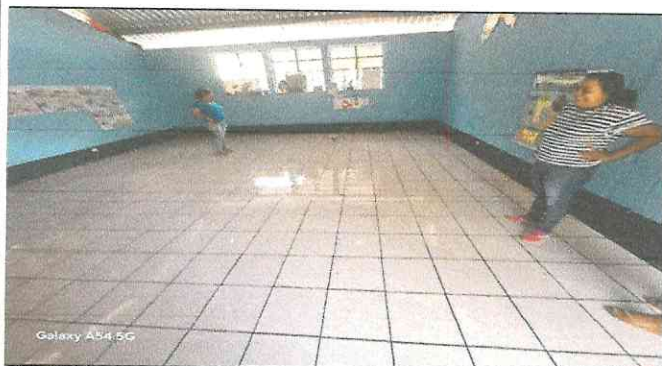
Finalizacion de pisos en aulas.
